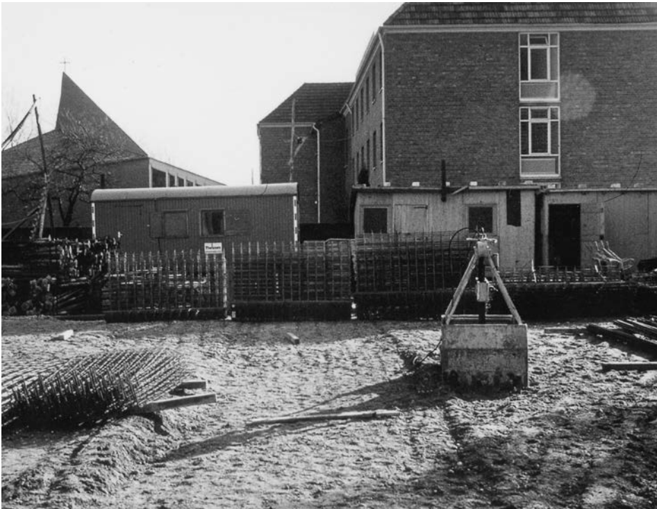
Die ersten Bauarbeiten am Franziskus-Haus. Rechts ist der 1956 errichtete Anbau des Mutter- hauses zu sehen, links die Kapelle.
