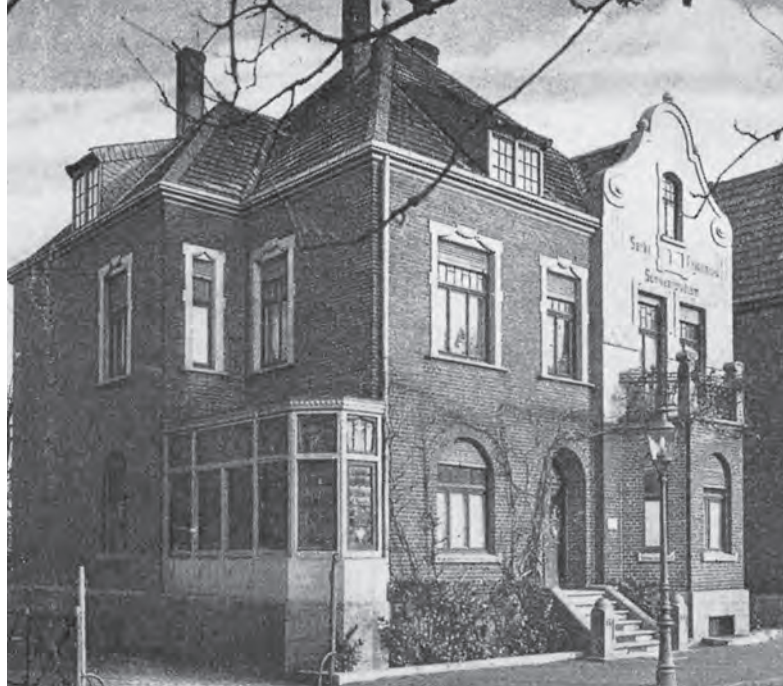
Das Mutterhaus an der Spycckstraße
